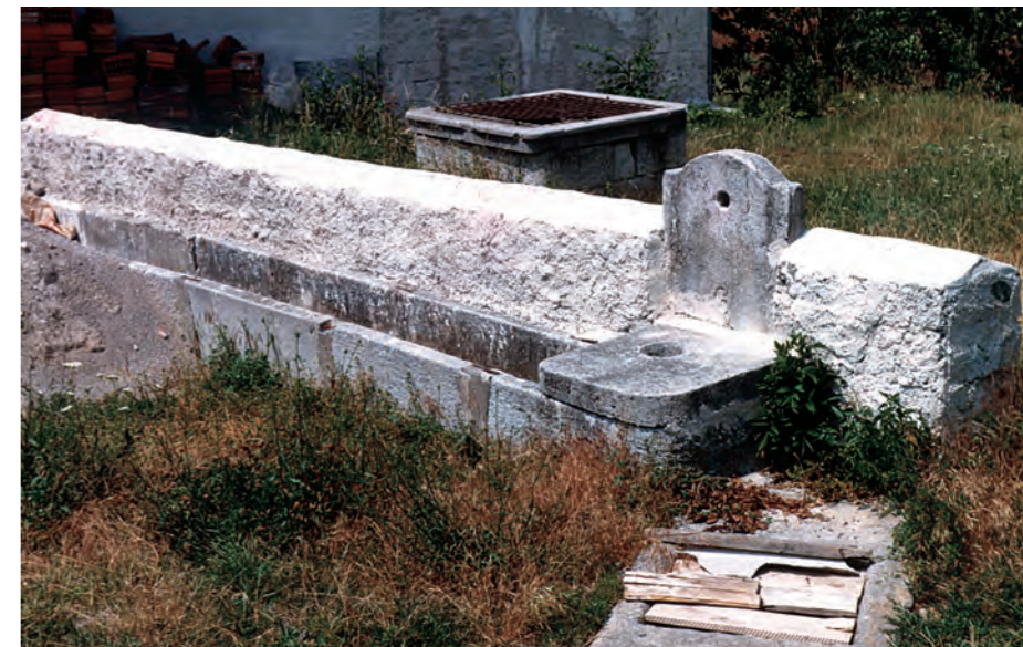
Vodnjak in napajališče na Krasu, opuščeno po priključitvi naselja na vodovod.
