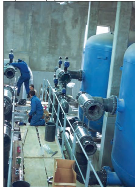
Montaža filtrirnih posod - Sela na Krasu
