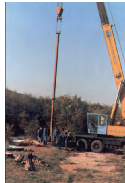
Postavljanje potopne črpalke v enega od treh vodnjakov v Klaričih
