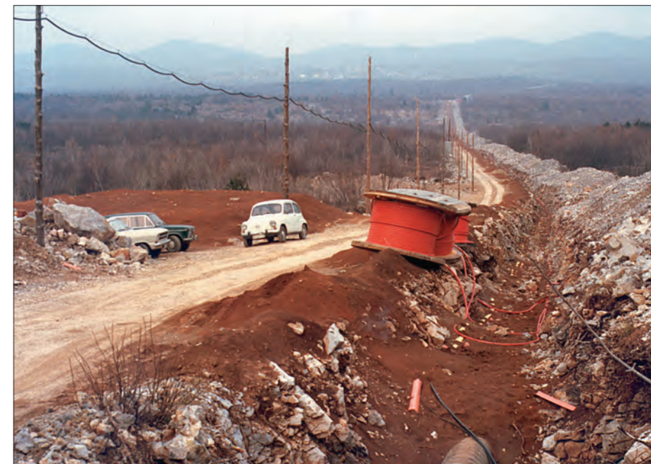
Vzporedno s cevovodom je na trasi položen dvojni kablovod za električno napajanje.
