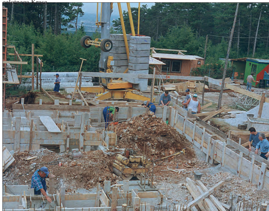
Gradbišče naprave za obdelavo surove vode na Selih na Krasu
