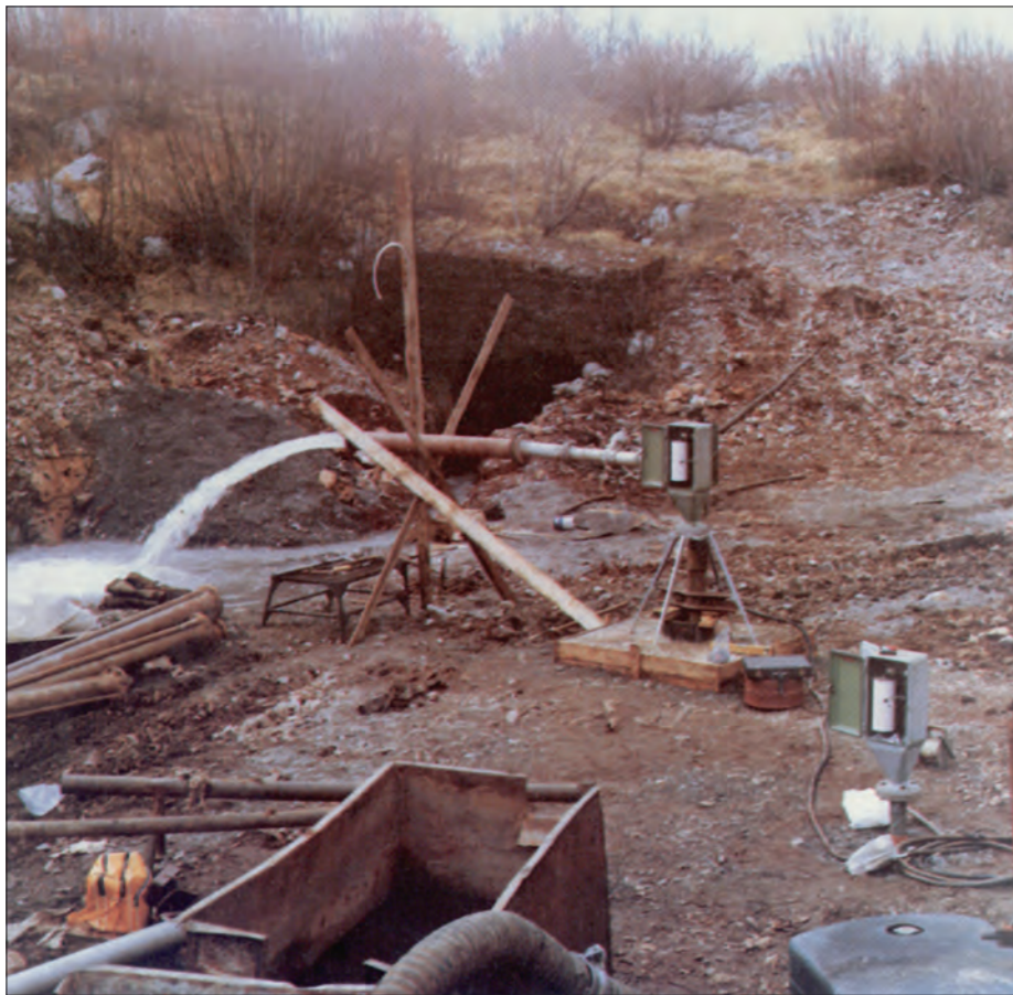
Vrtina VB-4 je bila locirana na podlagi predhodnih raziskav v okviru raziskovalne naloge »Podzemna voda v Tržaško-Komenskem krasu«. Vodnjak je bil izvrtan z vrtalnim strojem WITHL- 3 DO GLOBINE 70 M. Prvi črpalni poskus je bil dne 7. 3. 1980. Vodnjak je v poskusnem črpanju dajal do 53 l/s, kar je bilo več vode, kot jo je dobivala sežanska občina z vsem vodovodnim omrežjem vred in dvakrat več, kot jo je dobivala v sušnih obdobjih. Vzorec vode, ki ga je Geološki zavod Ljubljana poslal v analizo 22. 4. 1980, je Zavod SRS za zdravstveno varstvo ocenil kot pitnega: Bakteriološka in kemična sestava vode iz vodnjaka VB-4 ustreza z ozirom na vse analizirane komponente po »Pravilniku o higieni neoporečnosti vode, ki je namenjena za javno preskrbovanje prebivalstva kot za pitje ali izdelavo živil namenjenih za prodajo.«
